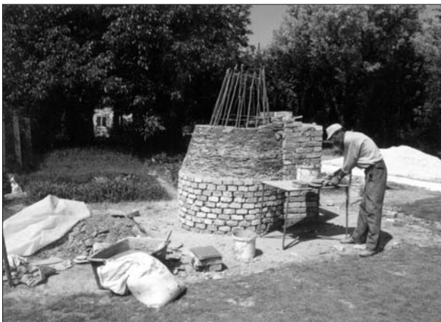
A kenyérsütő kemence építés közben
