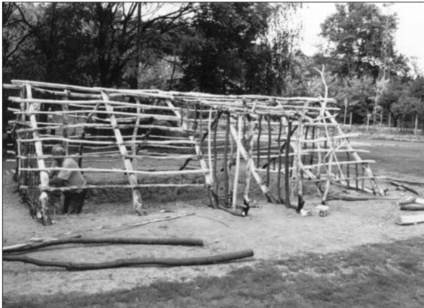
A veremház építés közben
