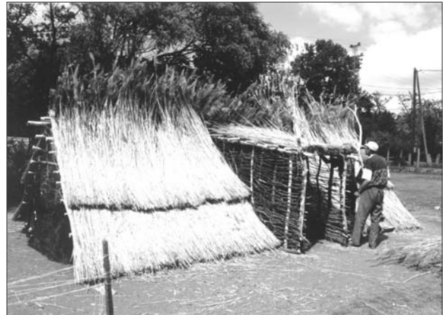
A veremház építés közben
