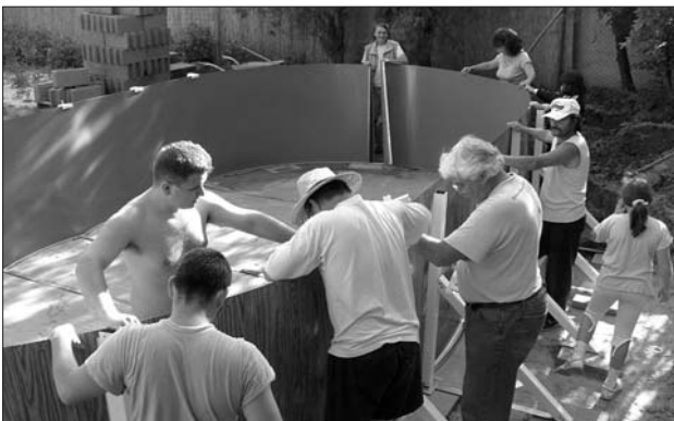
A medence építése
